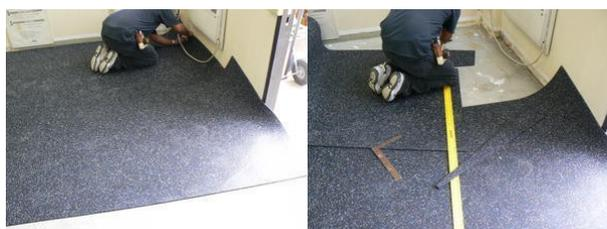
При нарезке используют обычный нож или нож с выдвижным лезвием. Для получения качественного среза, нужно делать не один, а несколько проходов ножом по покрытию, с каждым разом углубляя в него лезвие. Очень важна острота лезвия, поэтому чаще
