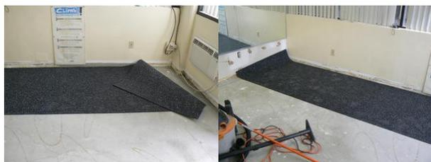
На основании ранее измеренных размеров помещения, из рулона нарезаются полосы покрытия и раскладываются на поверхности также, как они должны быть в дальнейшем наклеены. При нарезке необходимо оставлять запас по длине. Он необходим для
