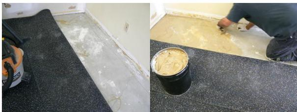
Наклейка начинается с крайней от стены полосы, которая по всей своей длине, осторожно, чтобы не произошло её смещения относительно других полос, заворачивается примерно наполовину вверх и на освободившееся под ней пространство
